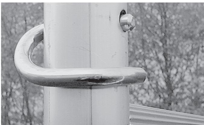
Alle Steckverbindungen müssen mit Fallsteckern gesichert werden.
