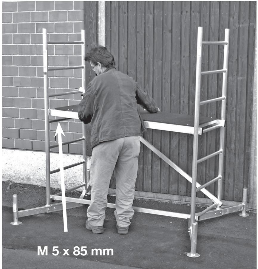
Die Abbildung zeigt das fertig montierte Grundgerüst.
