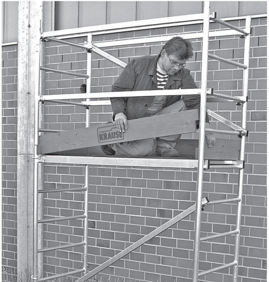
Die Abbildung zeigt den fertig montierten Seitenschutz.
