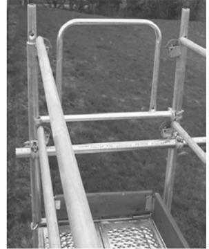
Anschließend werden das Stirnbordbrett und die Bordbretter auf die Stifte der Geländerpfosten aufgesteckt. Zuletzt werden alle Rahmenstöße mit Fallsteckern gesichert (siehe auch Sicherheitshinweise). Abschließend die Prüfung und Kennzeichnung unter Punkt 5.9 durchführen.
