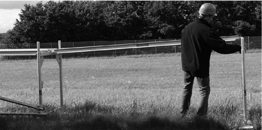
3.2.5 Optionale Leiter für die 1,20 m-Ebene über den Vertikalrahmen der Aufstiegsseite einhängen.
