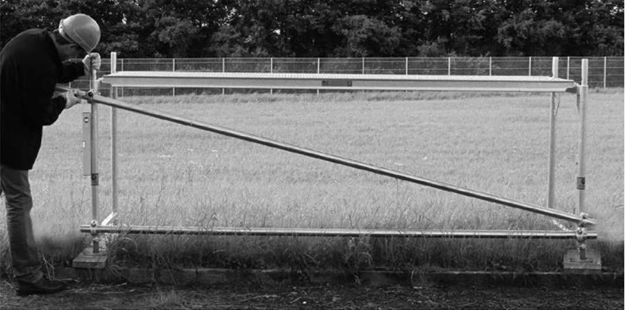
Anschließend sind die übrigen Beläge in die anderen Felder einzubauen und auf die gleiche Höhe mit Hilfe der Wasserwaage zu bringen.
