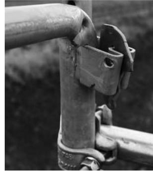
Geländerstreben mit den Keilen durch einen Hammerschlag fixieren.
